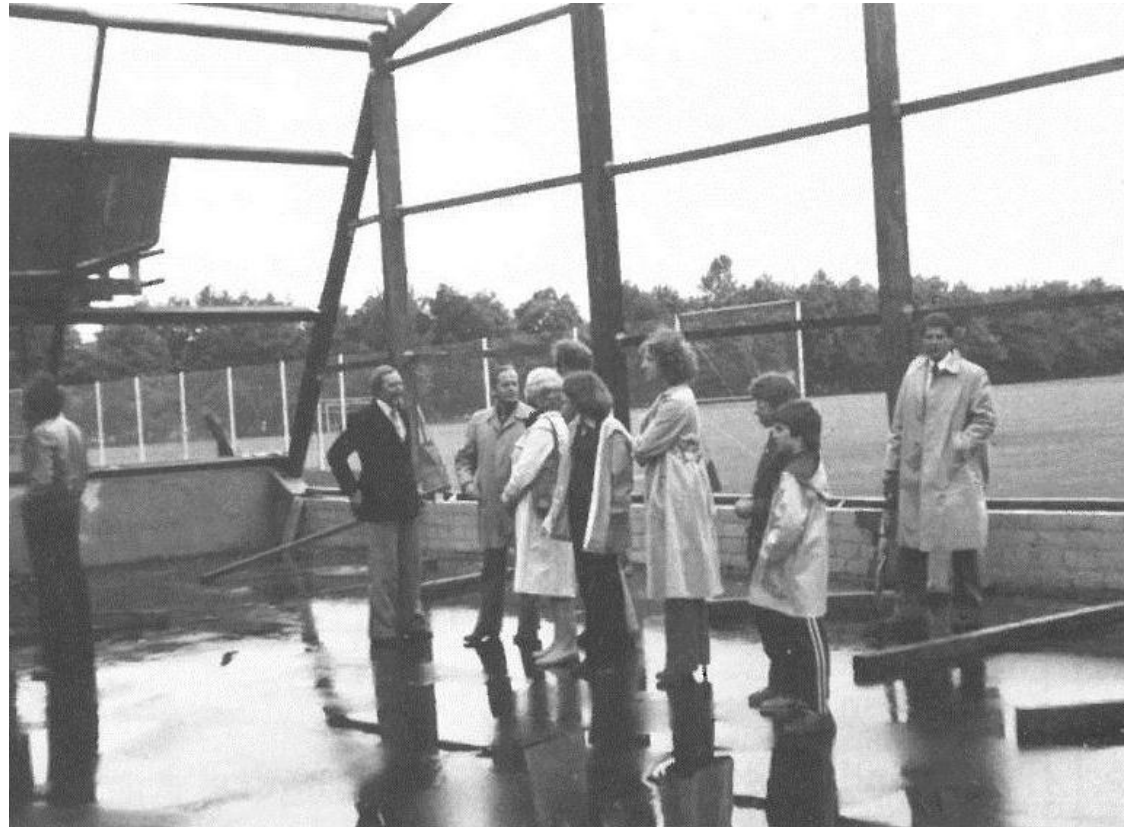
Richtfest der 1. Tennishalle 1978
